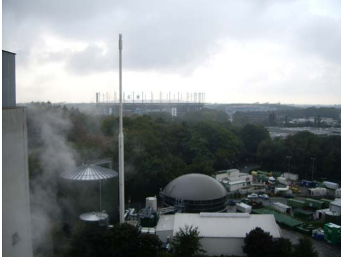
Biogas plant Biowerk Hamburg © IBBK
